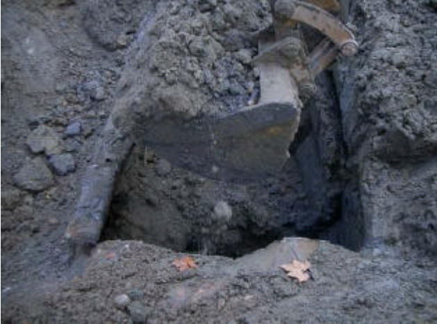
qualità del terreno prima del trattamento
